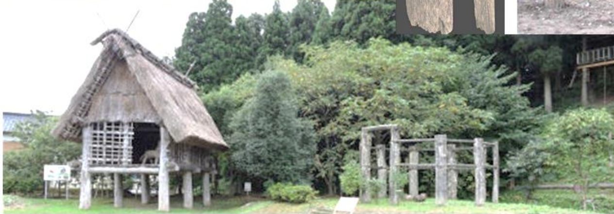
①貫穴付丸太柱の高床建物復元例
